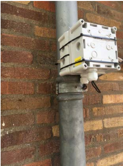
Foto's 1, 2 & 3, Ophangen / bevestigen met tie wraps, of met schroeven op een wand
